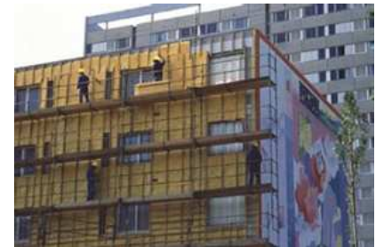
Isolation thermique par l'extérieur
