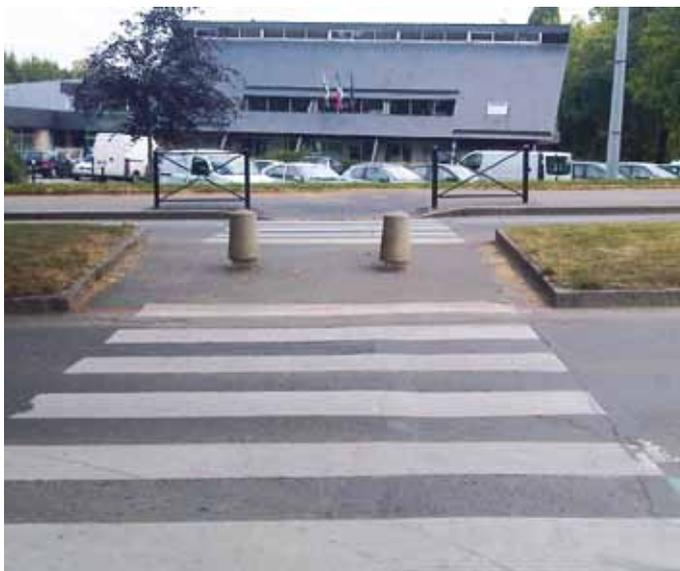
Parmi les travaux de mise en conformité, l'ajout de potelets aux normes et la pose de dalles podotactiles seront réalisés.
