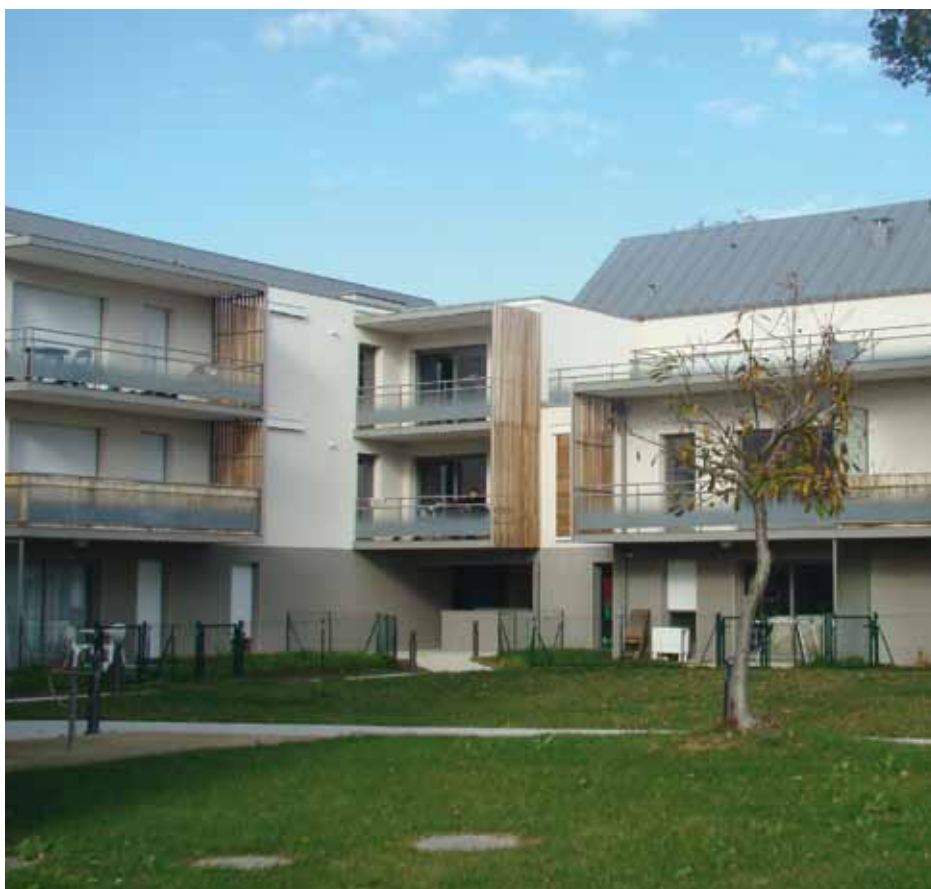
Le programme Villa di Trevi, un des derniers immeubles livrés sur le secteur du Pont Brand
