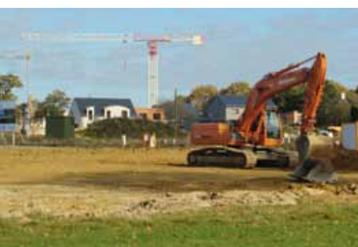
Le cabinet de kinésithérapie et les maisons sont en cours de construction
