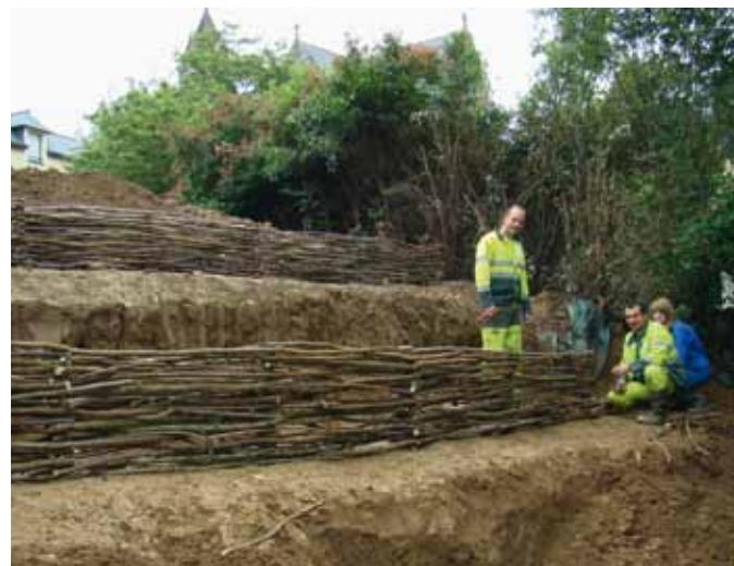
Réalisation d'une fascine en vue de créer un jardin en espalier
