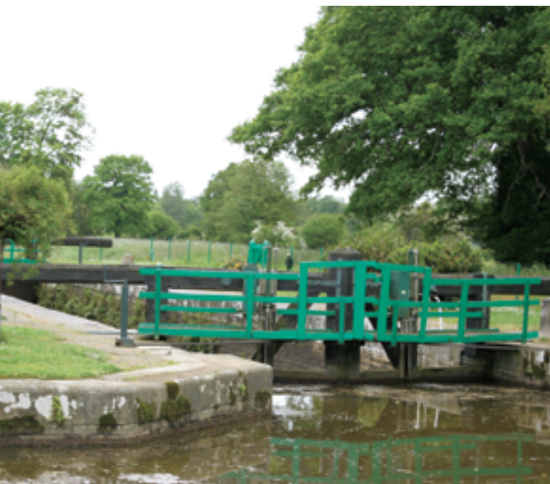
L'écluse du Haut Chalet.
