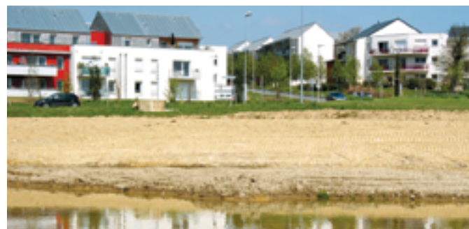
Le bassin tampon des Landelles sera achevé courant mai.
