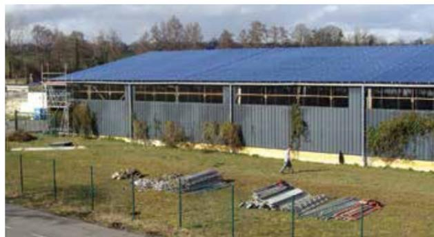
Des panneaux translucides ont également été installés le long du bâtiment en remplacement des translucides de toit. Ils permettront de continuer la manutention du compost dans des conditions de travail optimales.
