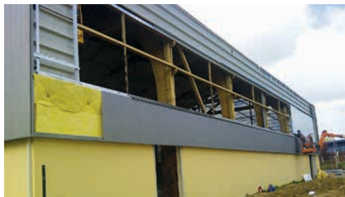
Pose de l'isolation extérieure et du bardage autour de la salle de sport.
