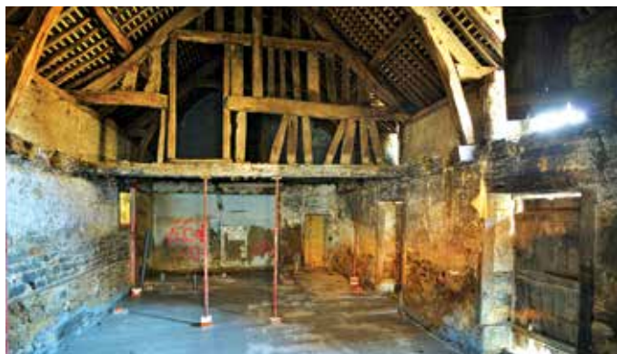
Une extension est en cours de réalisation.
