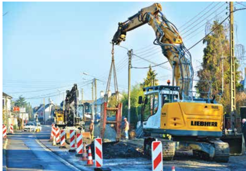
Les travaux progressent vers le centre-ville.
